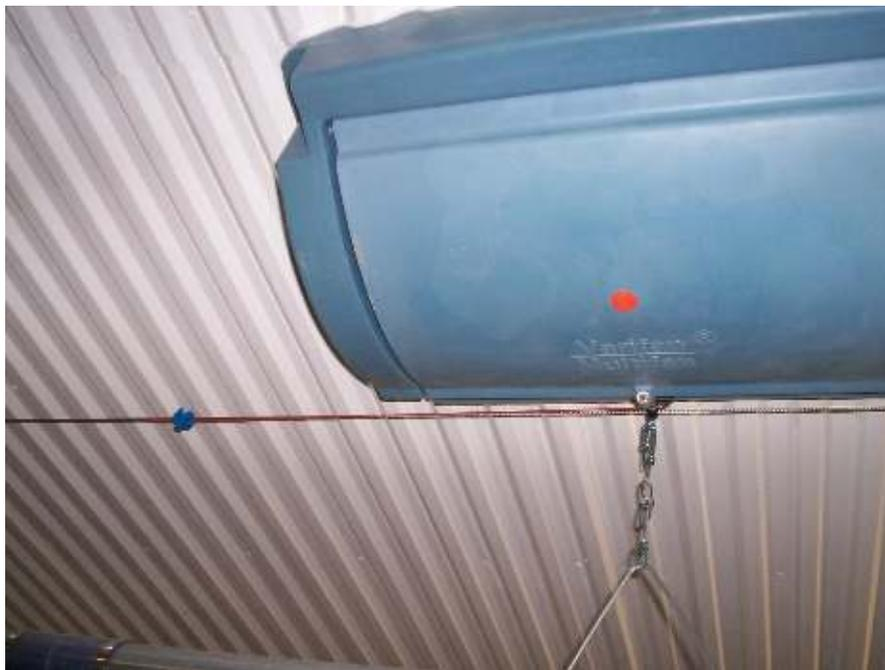
Figure 7: Exemple de connexion du câble de l'actuateur et de l'entrée d'air
