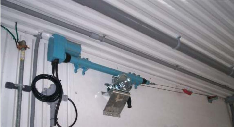
Figure 5: Exemple d'une installation d'un actuateur, d'une poulie et d'un treuil
